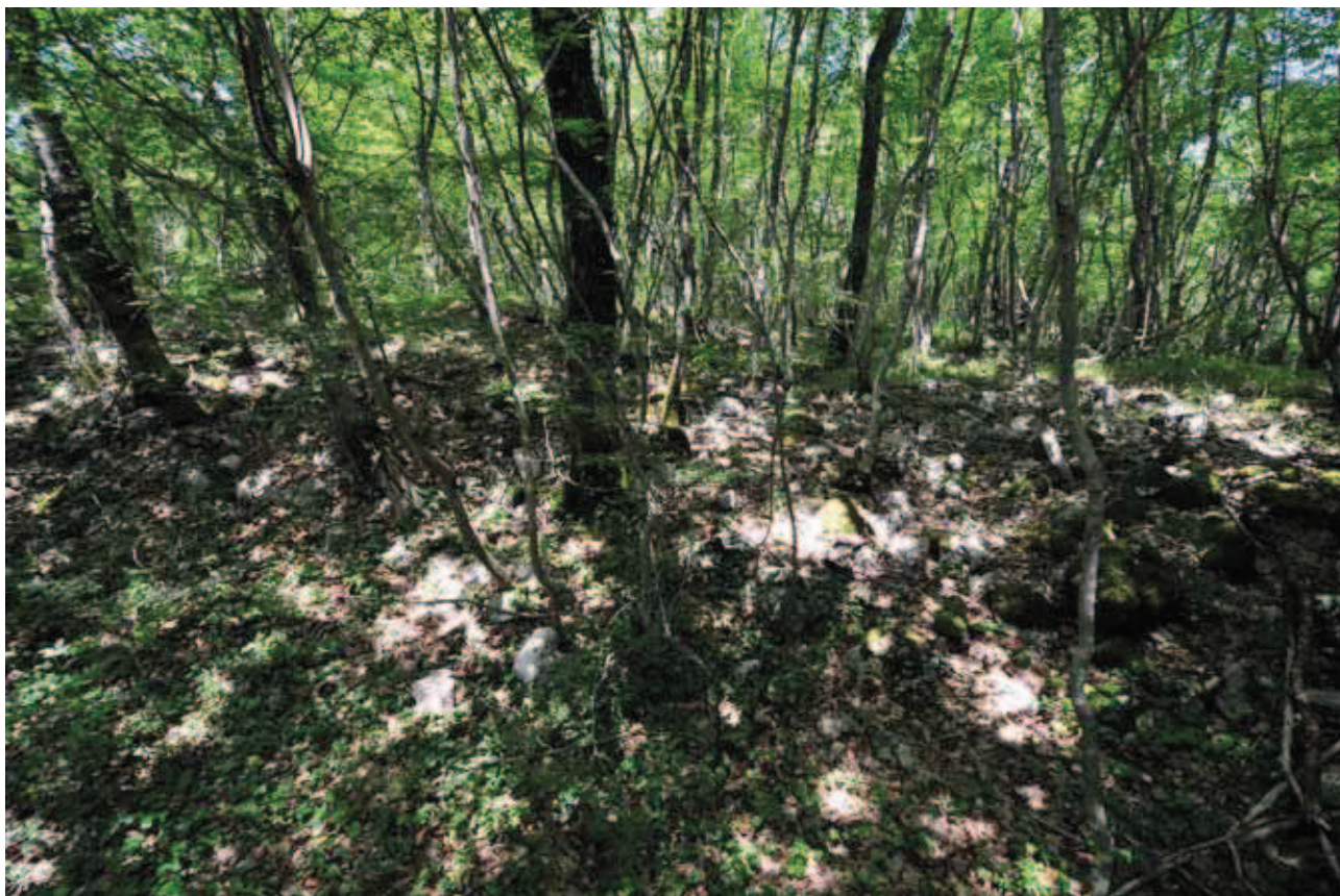
Sl. 5. Primjer urušenja zida građevinskog objekta (foto: D. Demicheli)
