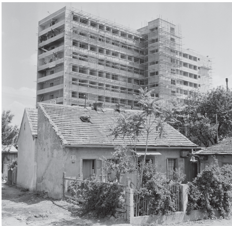
2. Trnje, izgradnja hotela International (HR-HDA-1422, Agencija za fotodokumentaciju)
